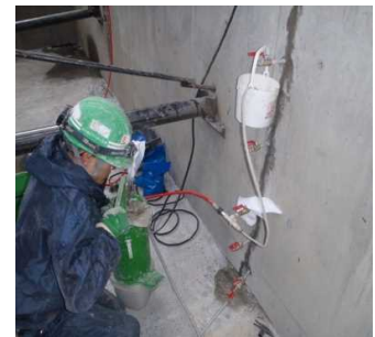
ひび割れ注入状況
