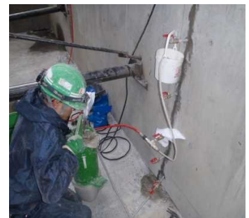
ひび割れ注入状況
