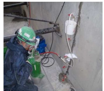
ひび割れ注入状況
