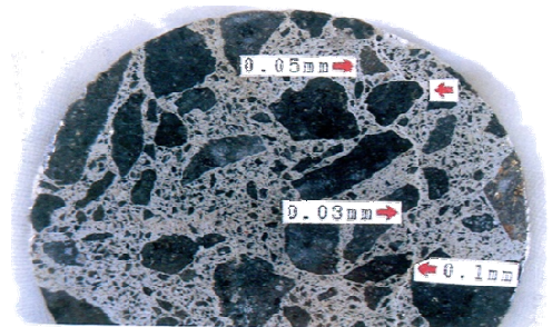
ハイスタッフのひび割れへの注入状況 (写真中の寸法はひび割れ幅です)
